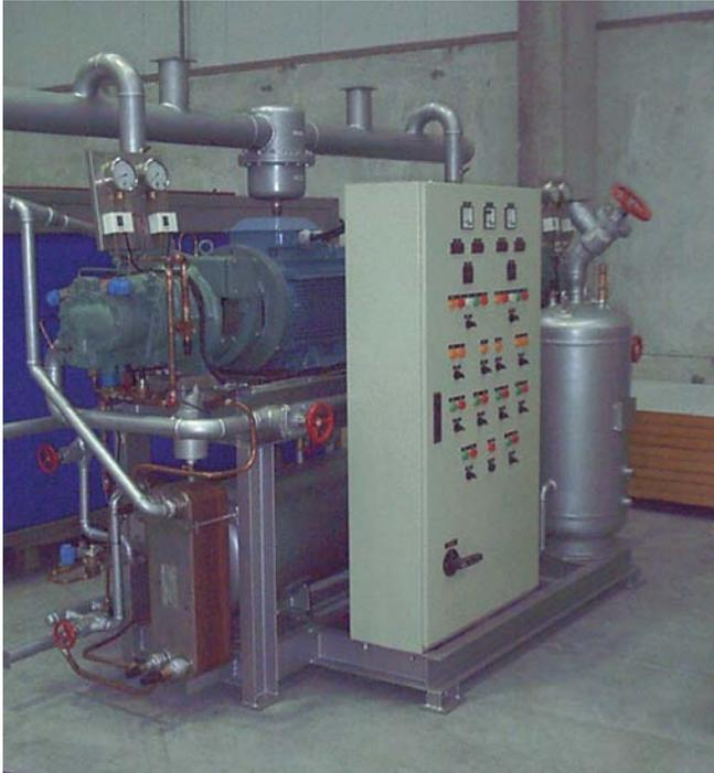
Unidad condensadora de 120 kW de potencia frigorífica a  $-40/+40^{\circ}\text{C}$  para congelar camarón en armarios horizontales.
